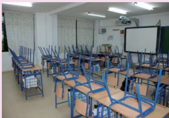
Reforma en aulas del Colegio Cerro de San Juan
