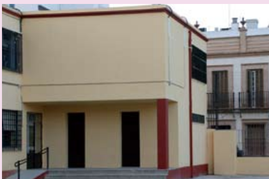
Construcción de tres nuevas aulas en Hipólito Lobato
