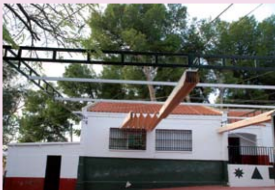
Instalación de toldos en la zona infantil en el Cerro
