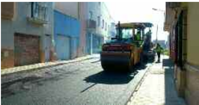
Obras en el barrio de Cantalobos.
