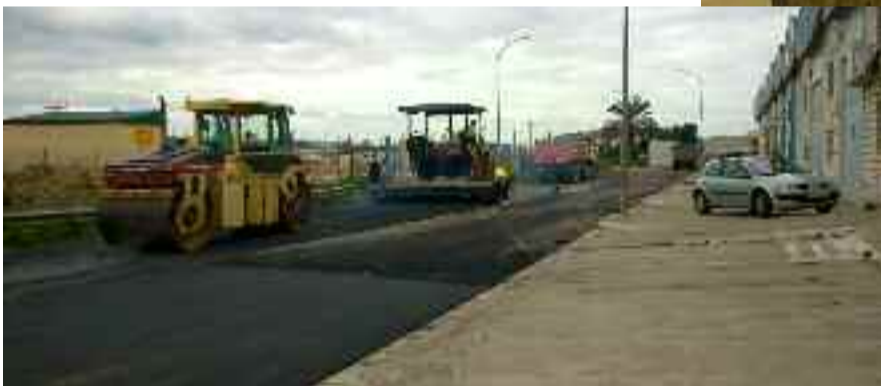
Pavimentación de zonas empresariales.
