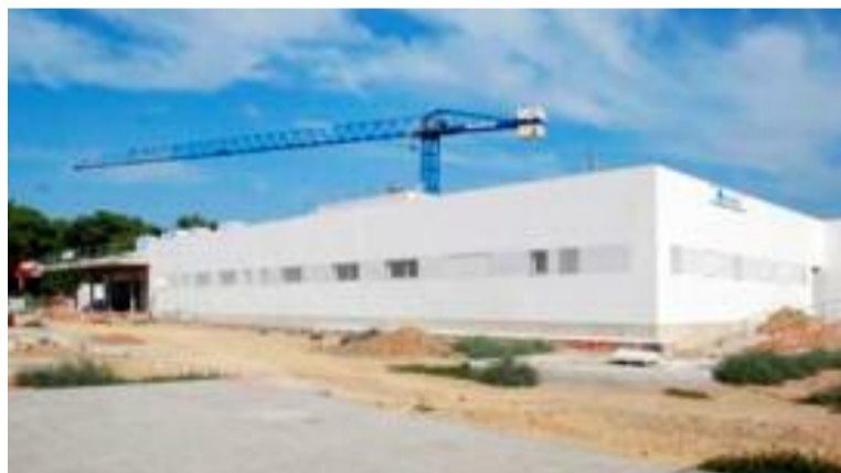
Obras en el Centro de Salud de Coria, situado en la zona de Tinajerías.
